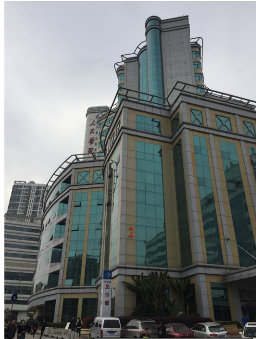
人民病院 2 号館の外観
