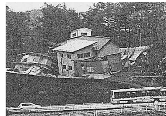
写真1. 4号国道(医大手前)の土砂崩れ(バスは医大行)
