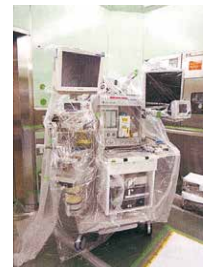
図② 麻酔器の養生。
