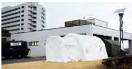
除染棟とテント
