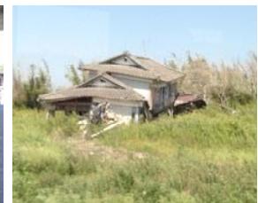
被災状況視察
