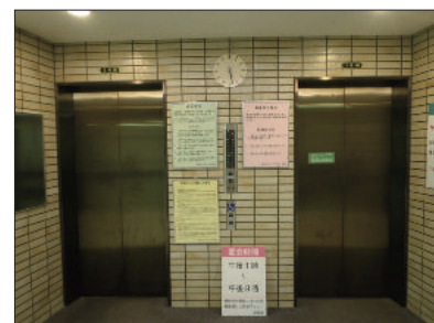
改修工事中の病院棟エレベーター1・2号機
